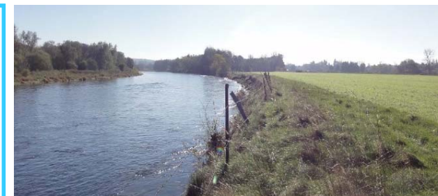
Moselle au niveau de l'extension (ENCEM)
