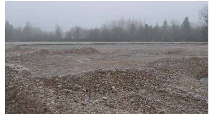
Surface décapée sur la zone en renouvellement (ENCEM)
